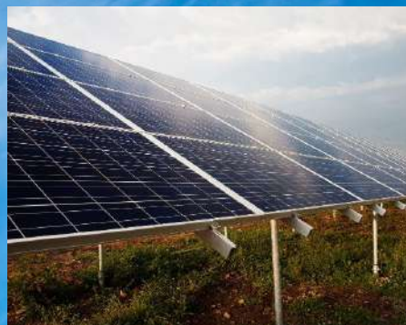
Figura 2. Formato “Open-Rack” Fotografía tomada de pixabay [4].
